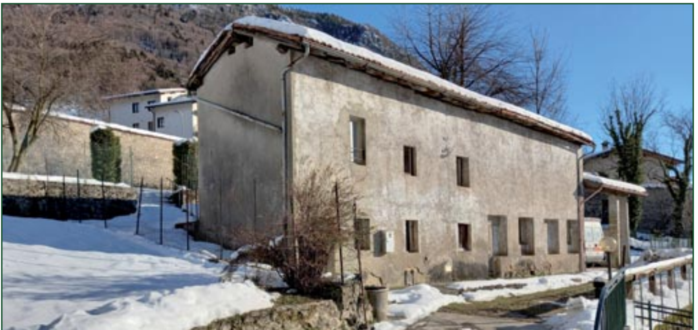
Il fabbricato da riconvertire a Scuola dell'Infanzia
