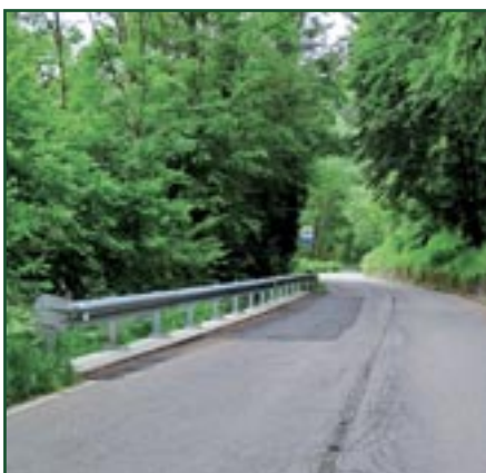
Nuovo muro di sostegno Serina Dossena
